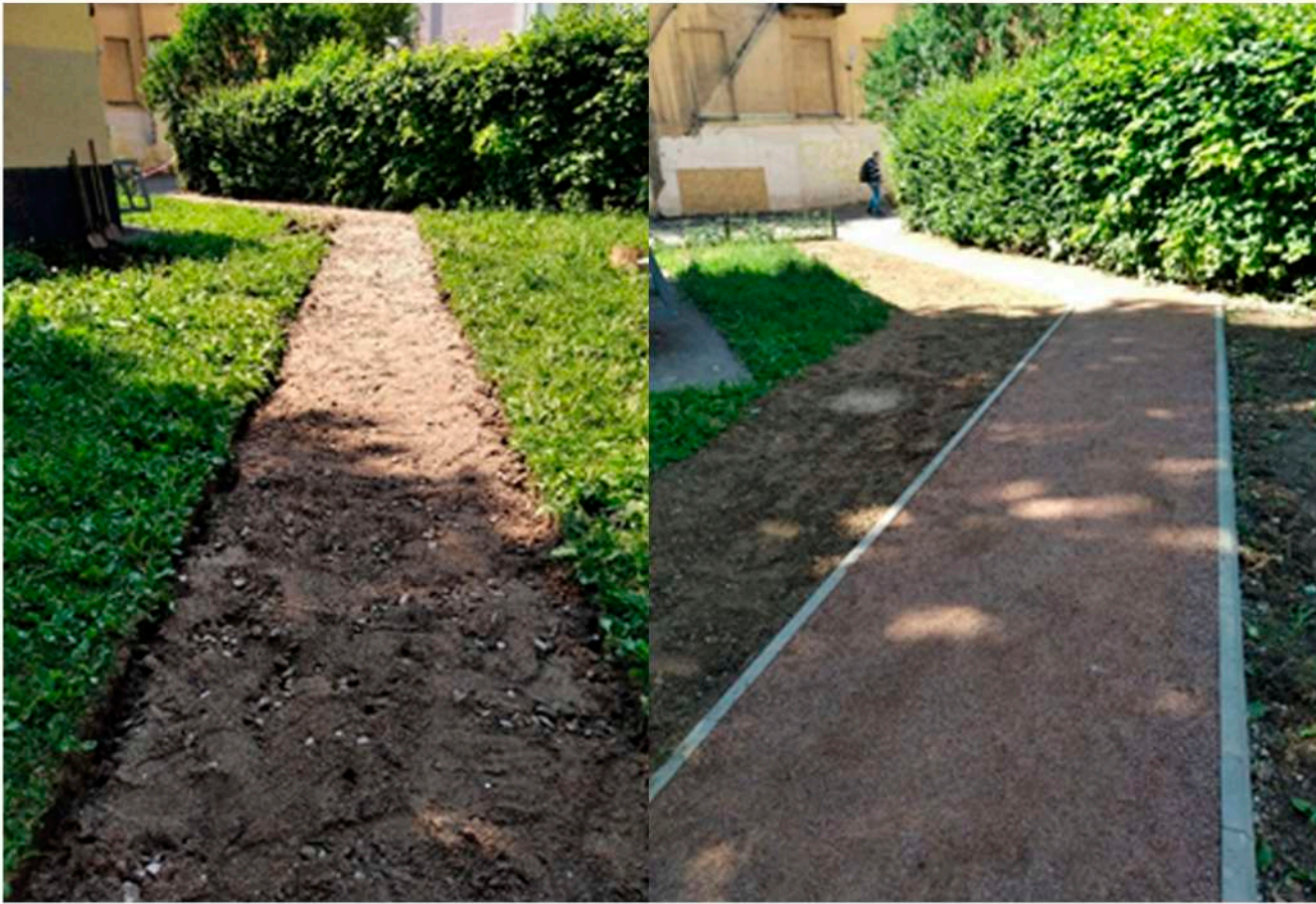
Ремонт дорожки с набивным покрытием - 65 кв.м.
