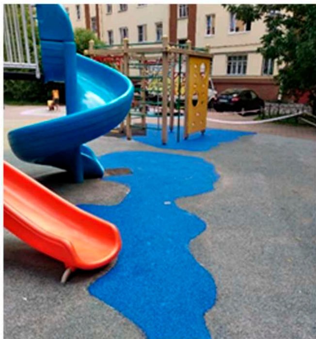
Ремонт покрытий на основе резиновой крошки - 52 кв.м.
