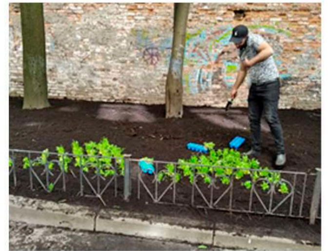
Ремонт газонов 180 кв.м.
